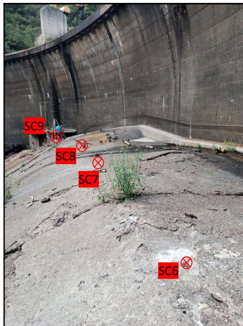
Figure 4 : Photos de l'implantation des sondages
