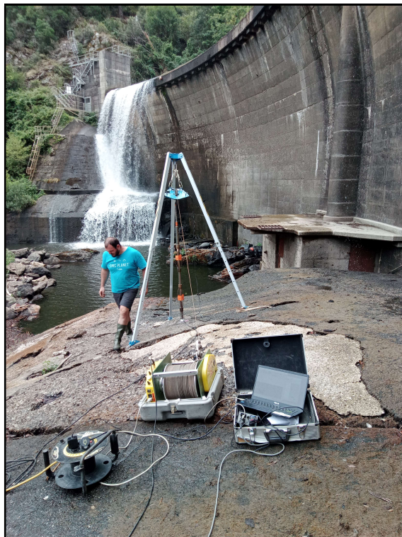
Figure 5 : Photos de l'imageur de paroi et de la mise en station sur le sondage SC9
