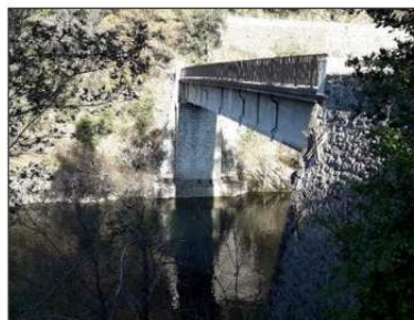
Pont où l'espèce niche, à l'aval proche du barrage de Sainte-Cécile-d'Andorge
