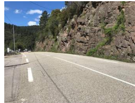
RN106 au droit du barrage vers Mendé
