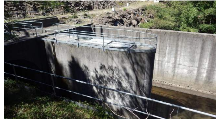
Photographie 7 : Chambre de restitution aval, vue depuis l'aval du barrage
