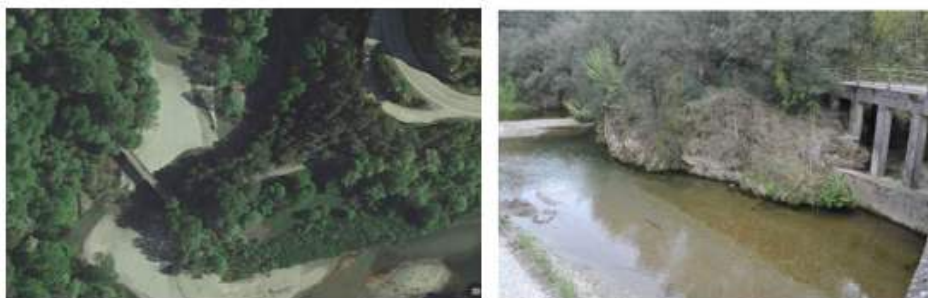
Vues de la station amont 0 – Pont en amont de la retenue de Sainte-Cécile d'Andorge
