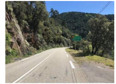
RN106 au droit du barrage vers Alès
