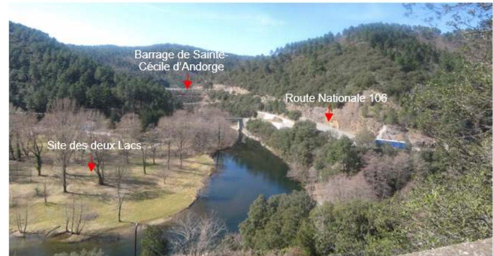
Figure 28 : Le Site des Deux Lacs, site retenu pour les installations de chantier du projet de sécurisation du barrage de Sainte-Cécile d'Andorge
