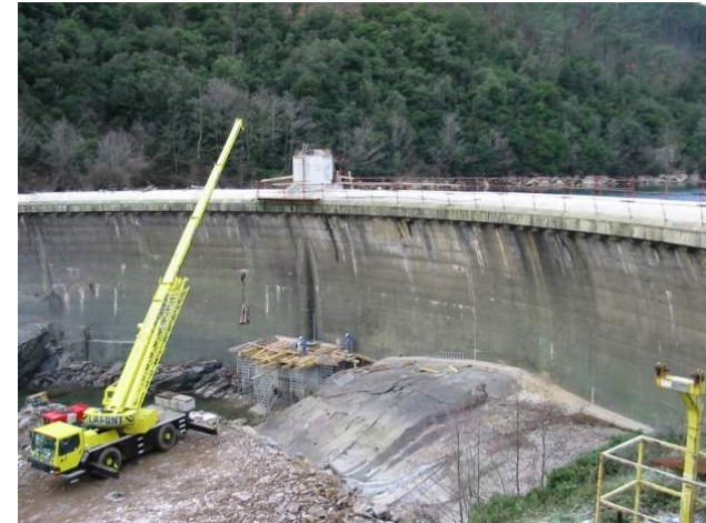
Photographie 11 : Plateforme de travail des travaux de 2002/2003
