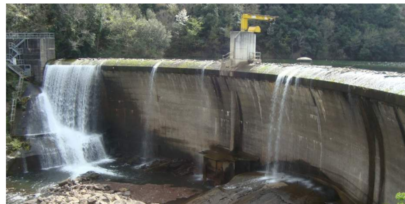
Photographie 18 : Le barrage des Cambous (avril 2019)
