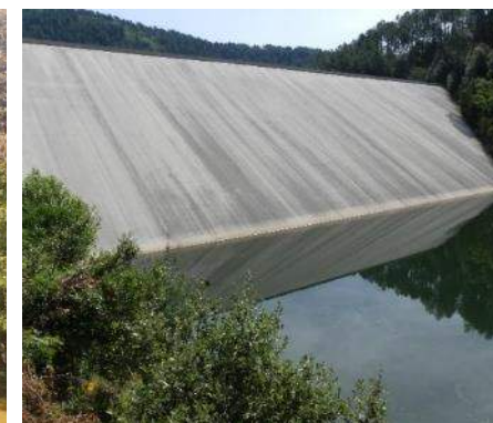
Barrage nord côté amont
