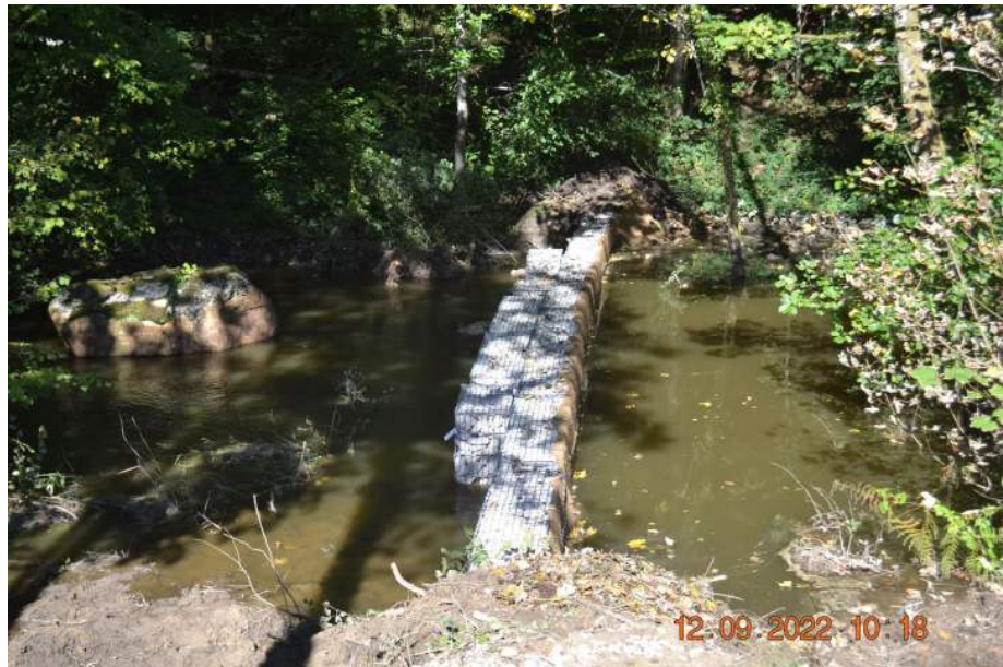
Figure 16 : Dispositif de barrage filtrant mis en œuvre dans le cadre de la vidange du barrage des Settons
