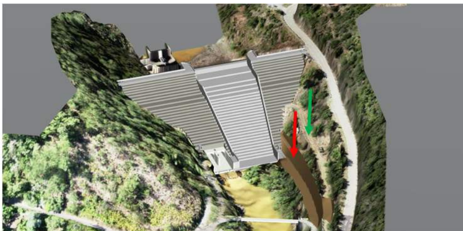
Figure 4: Création d'un accès au barrage en rive gauche (flèche rouge) et confortement de la piste existante (ancienne RN 106) (flèche verte)
