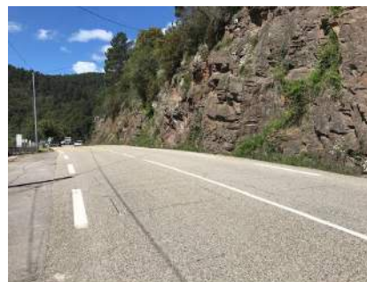
RN106 au droit du barrage vers Mende
