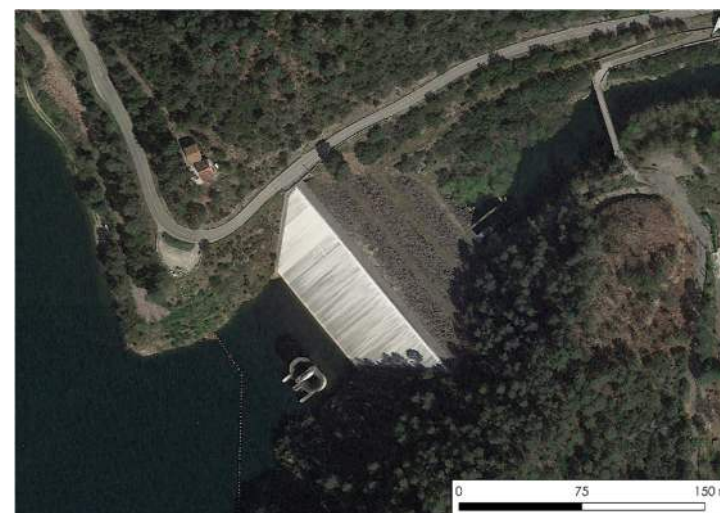
Carte 56 : Emprise au sol du barrage actuel
