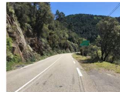
RN106 au droit du barrage vers Alès
