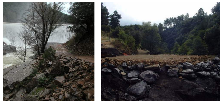
Photographie 1 : Plateforme et piste d'accès créer pour les travaux de 2002 / 2003
