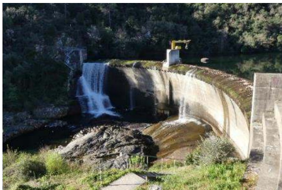
Barrage sud côté aval
