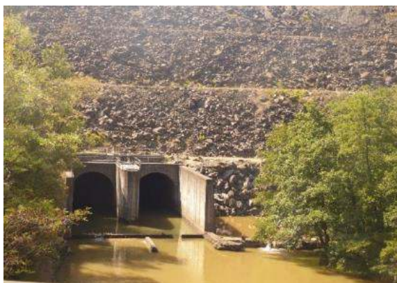
Barrage nord côté aval
