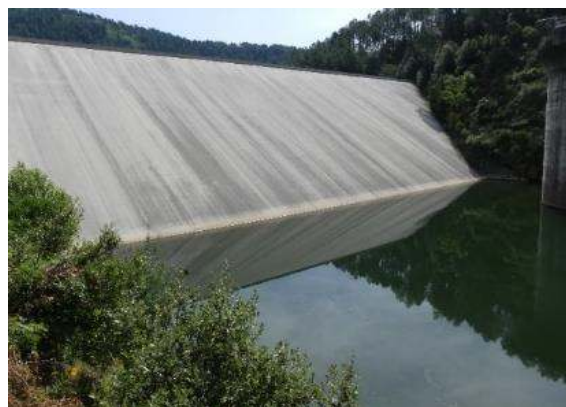
Barrage nord côté amont
