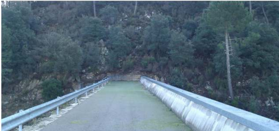
Photographie 8 : Vue sur la crête du barrage de Sainte-Cécile-d'Andorge depuis la Route Nationale 106 (à droite, partie amont de l'ouvrage)
