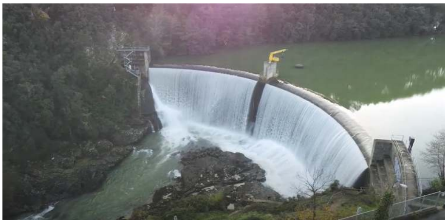
Photographie 4 : Le barrage de Cambous
