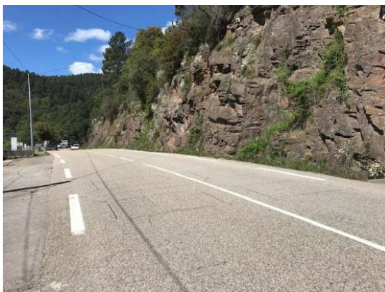
RN106 au droit du barrage vers Mende
