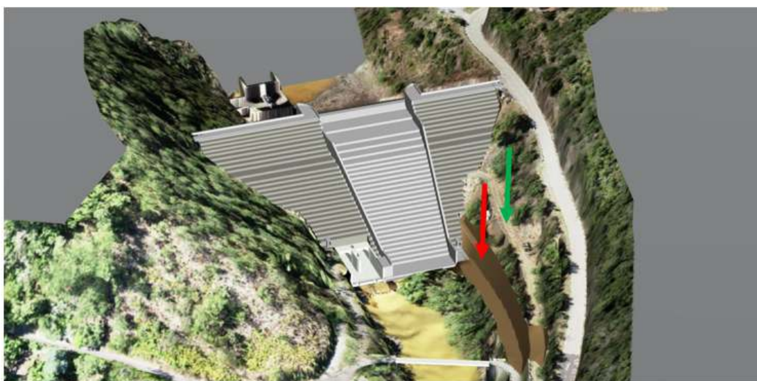
Figure 20 : Création d'un accès au barrage en rive gauche (flèche rouge) et confortement de la piste existante (ancienne RN 106) (flèche verte)
