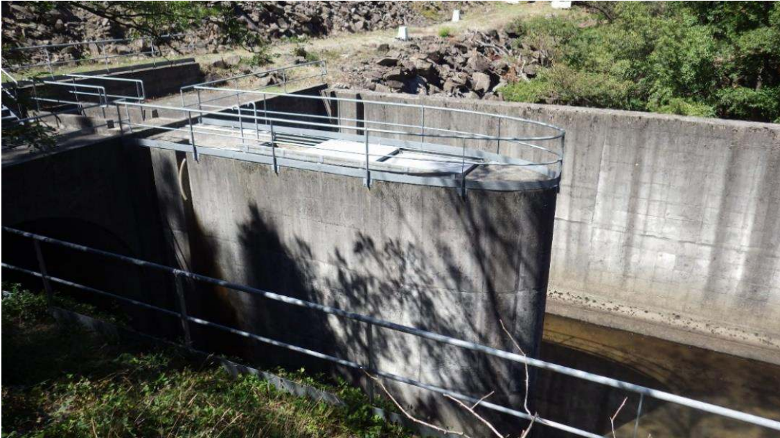
Photographie 10 : Chambre de restitution aval, vue depuis l'aval du barrage
