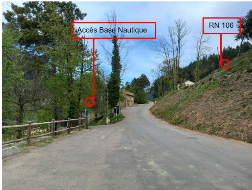
Photographie 5 : Voie d'accès en enrobé menant à la zone d'installation de chantier
