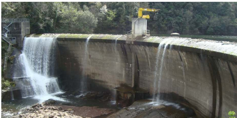
Photographie 3 : Le barrage de Cambous (avril 2019)
