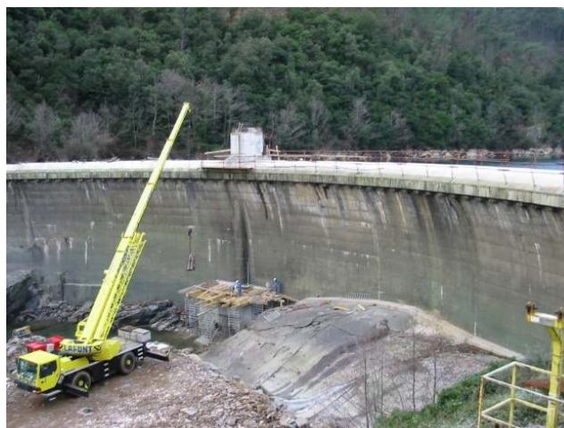
Photographie 6 : Plateforme de travail des travaux de 2002/2003
