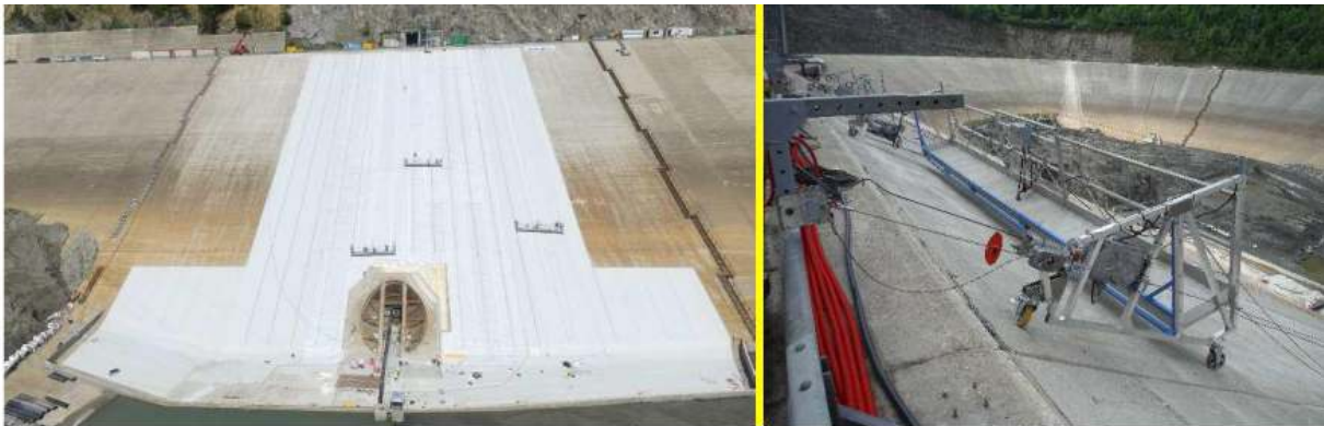
Photographie 9 : Nacelles suspendues mobilisées dans le cadre des travaux sur La Coche en 2018
