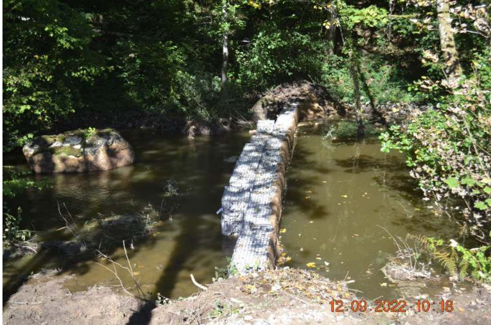
Figure 28 : Dispositif de barrage filtrant mis en œuvre dans le cadre de la vidange du barrage des Settons
