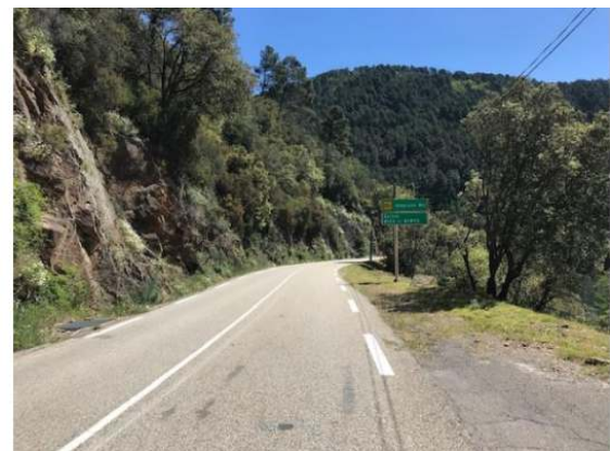
RN106 au droit du barrage vers Alès
