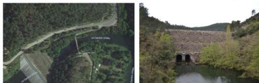
Vues de la station aval 2 – Aval immédiat du barrage de Sainte-Cécile d'Andorge
