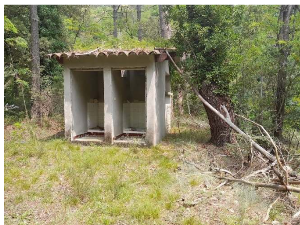
Anciennes infrastructures de camping
