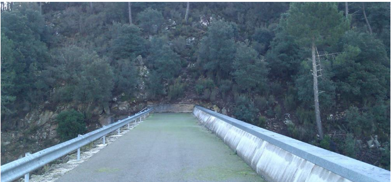
Figure 88 : Parapet à démolir, glissière à déposer et bitume à décaper
