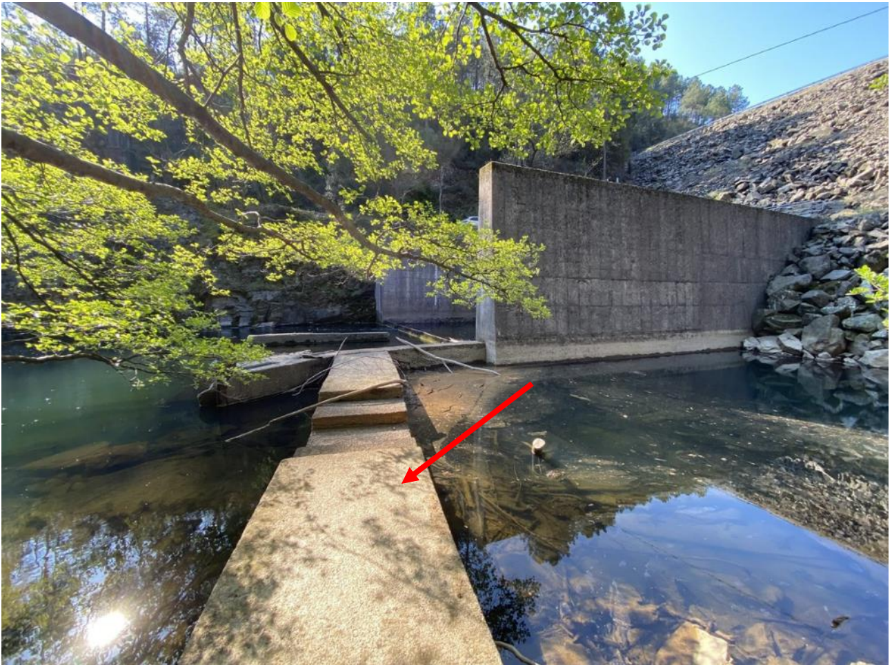
Figure 87 : Seuil à démolir
