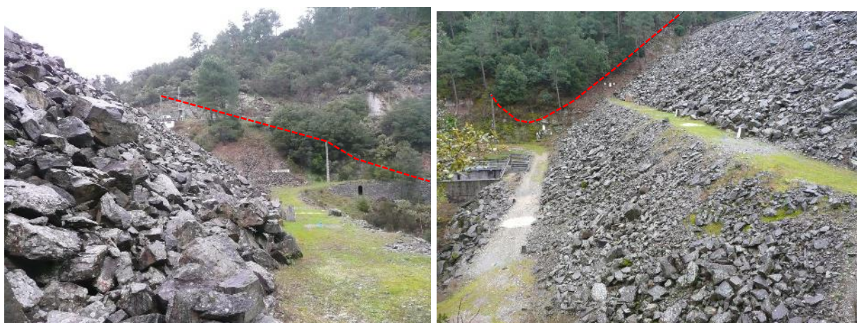
Figure 195 : Réseau électrique aérien existant
