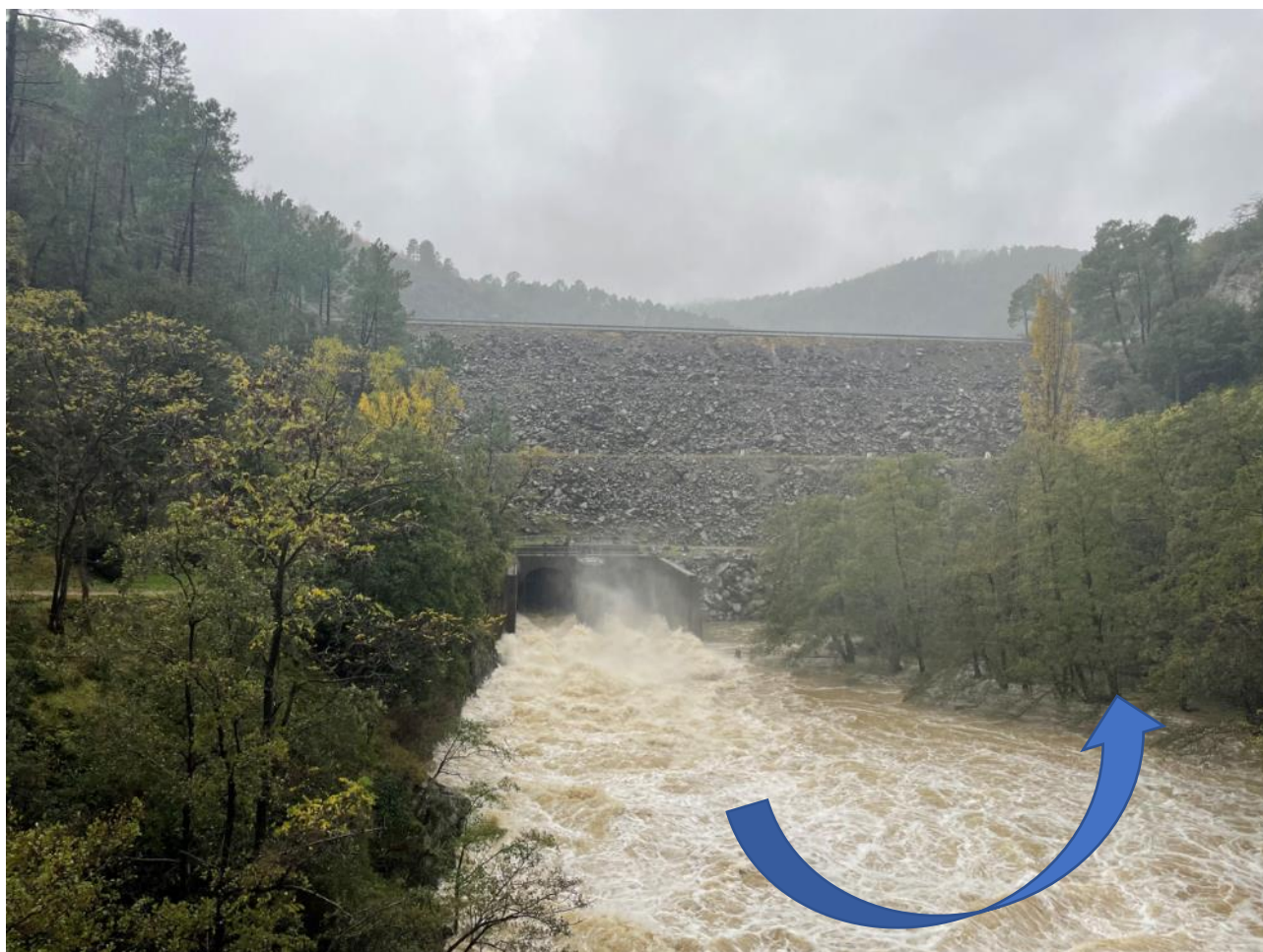
Figure 147 : Courant de recirculation observé lors de la crue d'octobre 2021
