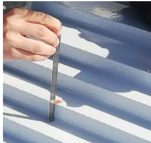
Figure 22 : Mesure dans le coursier
