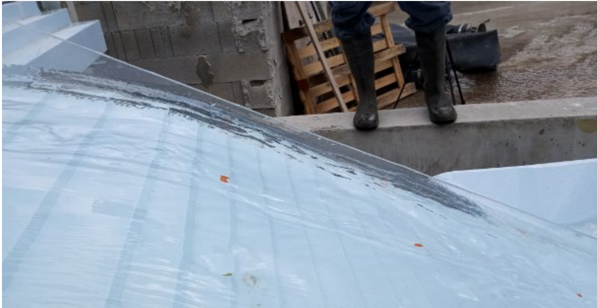
Figure 45 : Revanche suffisante dans le coursier pour la crue Q100 000
