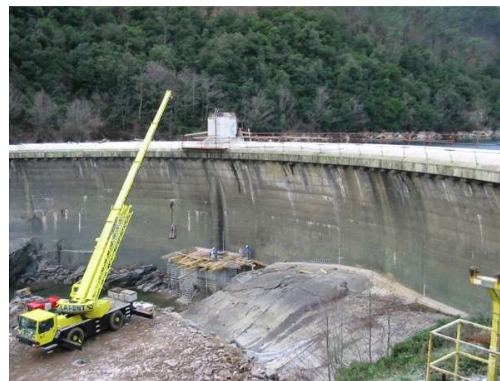
Photographie 4 : Plateforme de travail des travaux de 2002/2003
