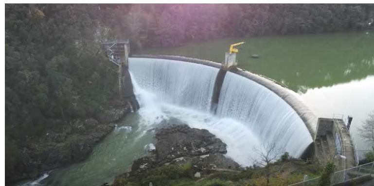
Photographie 3 : Le barrage des Cambous
